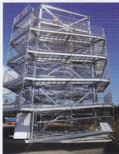
(御前崎市に完成した津波避難櫓)
